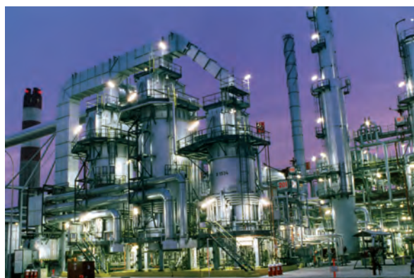
Raffinerie: Wettbewerbsvorteile beim Projektmanagement durch exakte Planung
